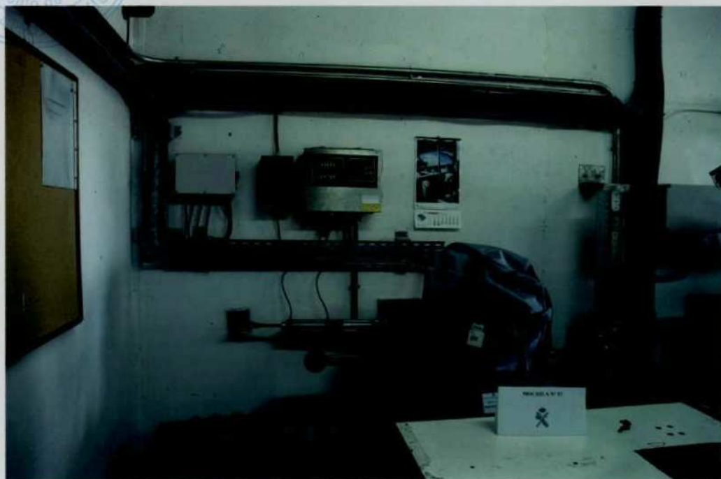
IMAGEN Nº 6 (vista general pesaje bolsa nº 13)
