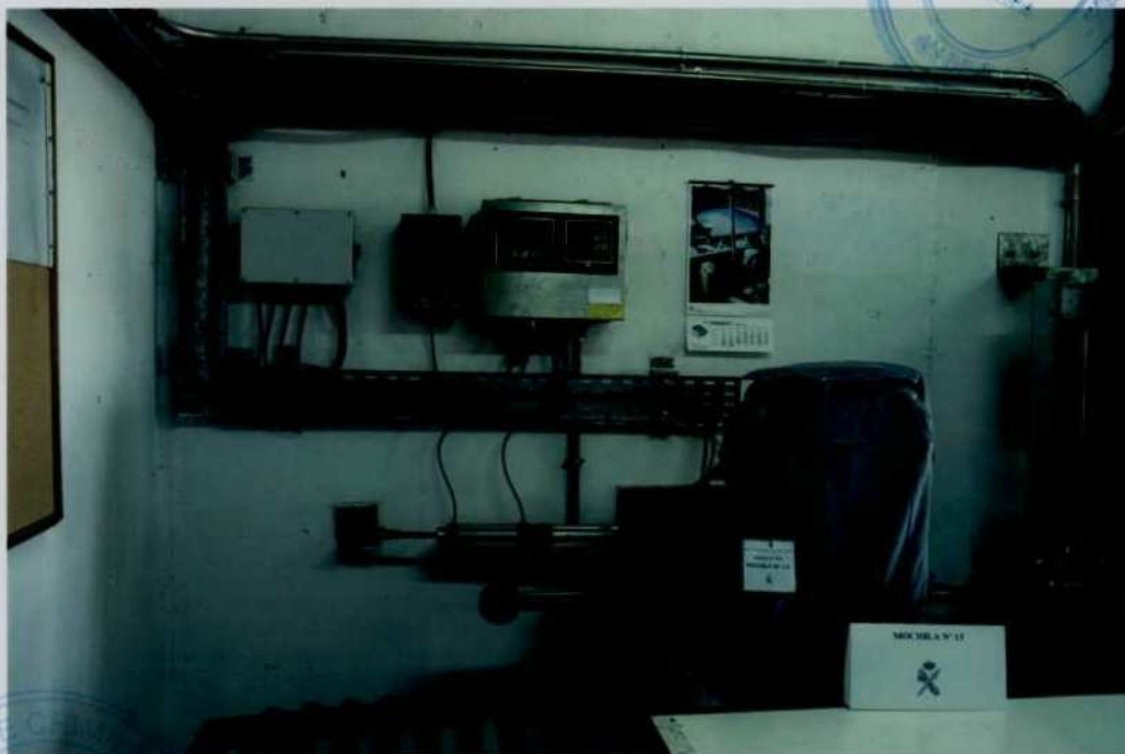
IMAGEN N° 19 (vista general pesaje bolsa n° 13 con explosivo)
