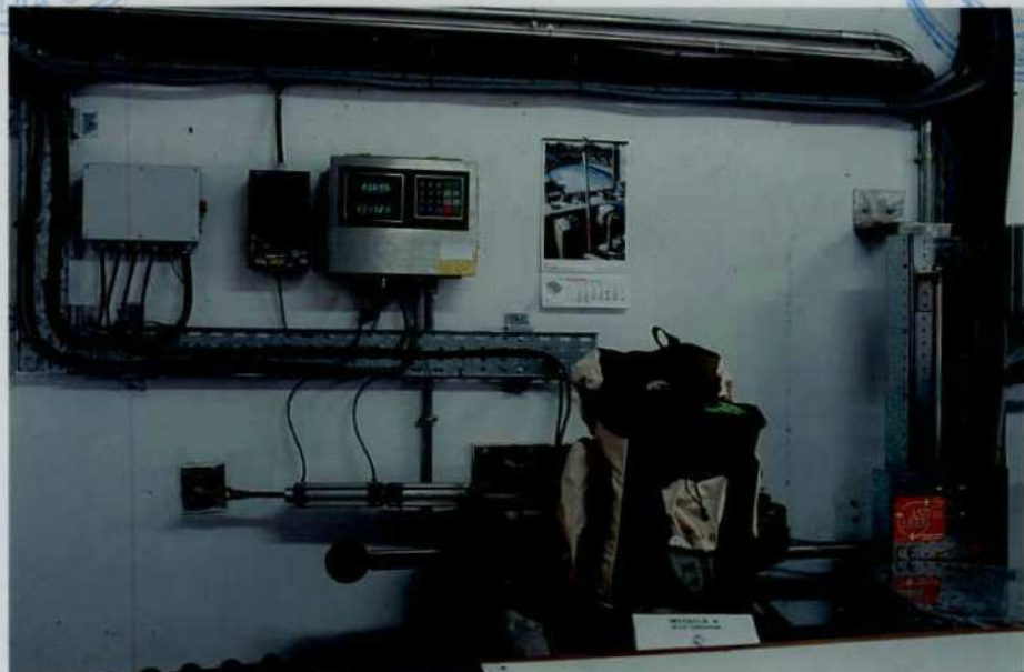
IMAGEN N° 14 (vista general de pesaje mochila A, con explosivo)
