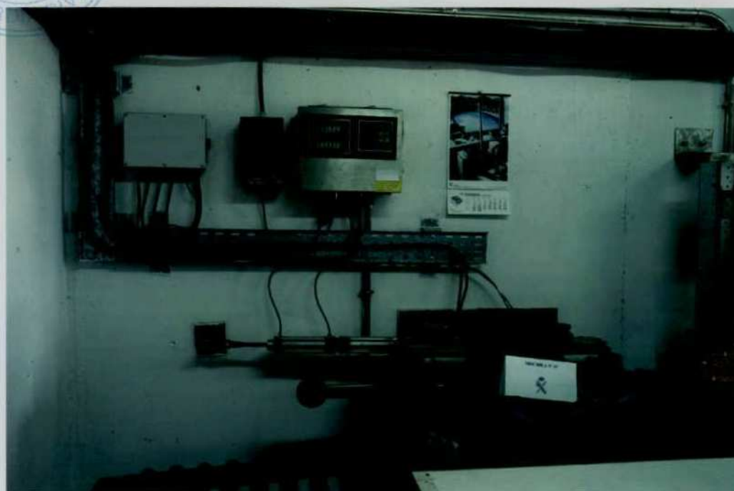
IMAGEN N° 36 (vista general pesaje bolsa n° 15 con explosivo)
