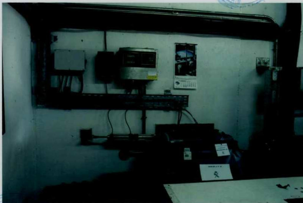
IMAGEN N° 41 (vista general pesaje bolsa n° 13 con caja de explosivo)
