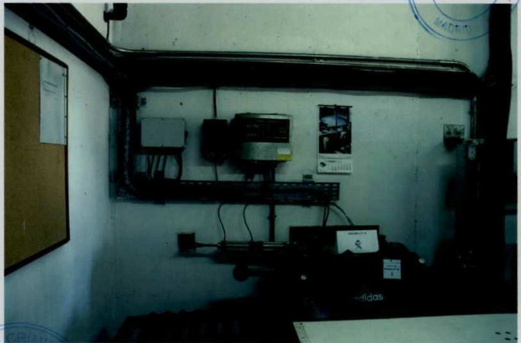
IMAGEN N° 29 (vista general pesaje bolsa n° 18 con explosivo)
